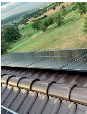
Installiert wurden 12 Module mit einer Leistung von 390 Watt pro Modul. In Summe ergibt sich somit eine mögliche Spitzenleistung von 4,68 kWp. Ein Teil des Stroms wird selbst genutzt. Der überschüssige Strom wird ins Netz eingespeist, wofür der Verein eine Vergütung erhält. Es grüßt die Vorstandschaft.
